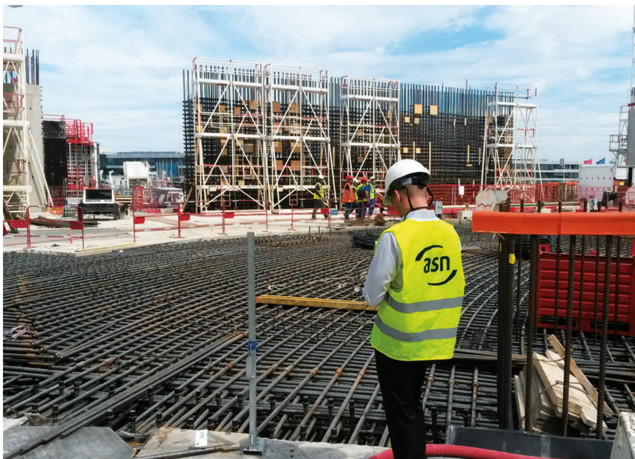
| Inspection de l'ASN sur le chantier du réacteur Tokamak de ITER, mai 2017.
