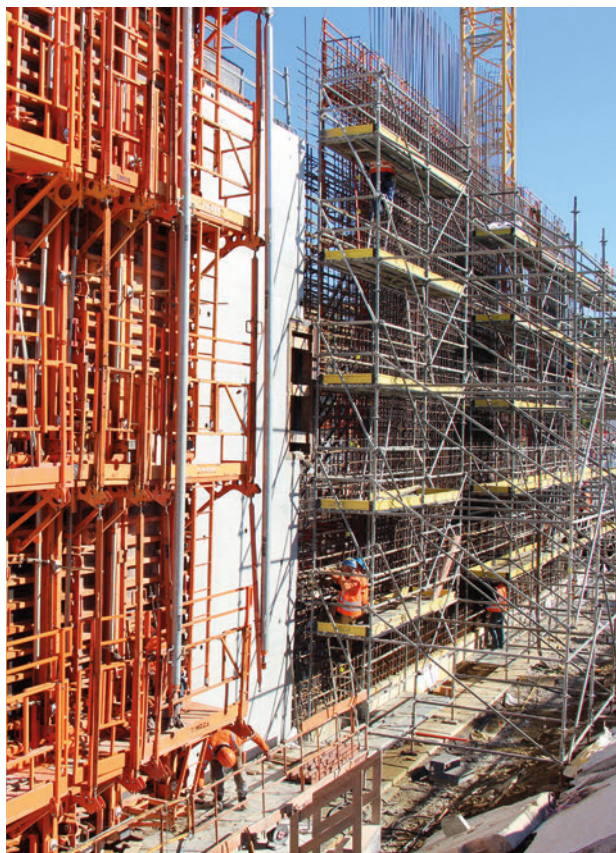
Chantier de construction de Diadem, septembre 2015.
