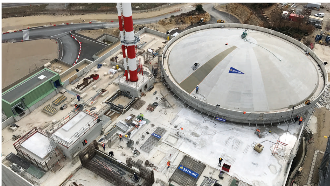
Travaux de toiture sur le RJH, mars 2017.
