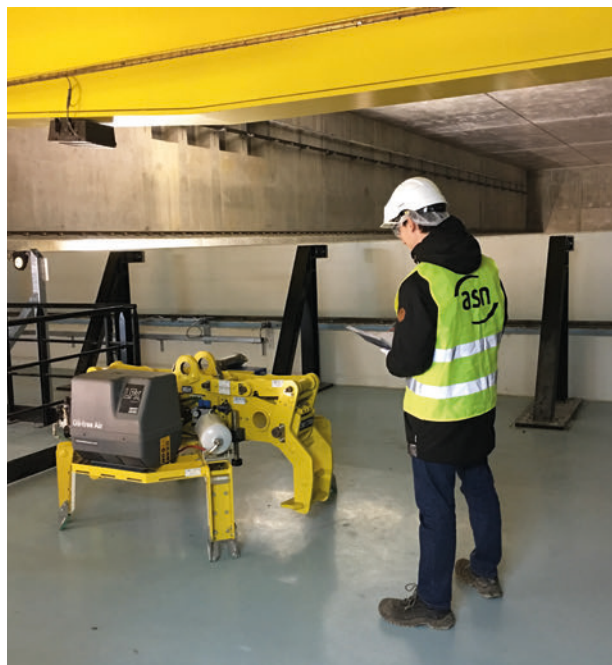
Chantier de construction d'Iceda, 2017.
