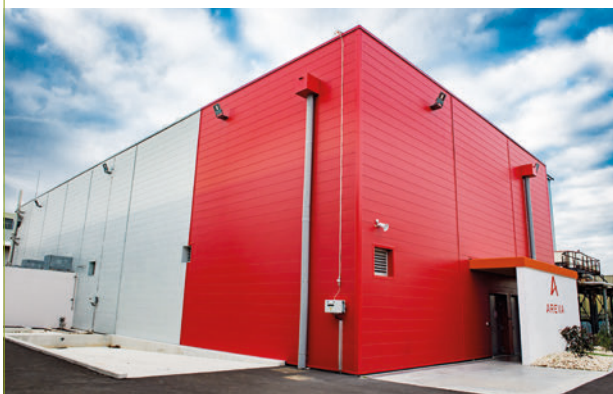
Le bâtiment commandement du site du Tricastin.
